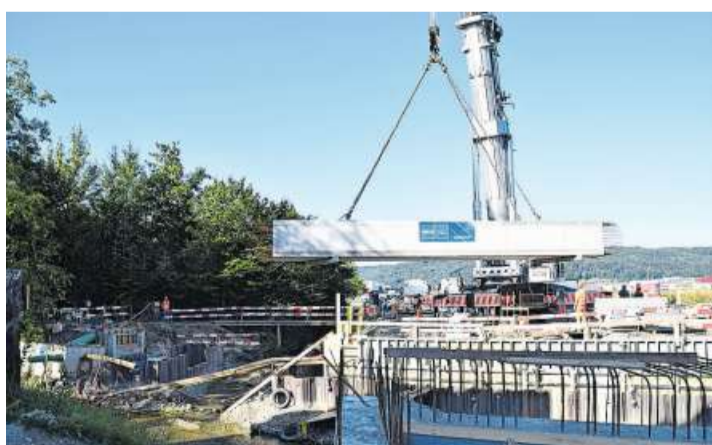
Am Kran hängt der Kanal hier noch in der Luft. Bild: Laura Koller
